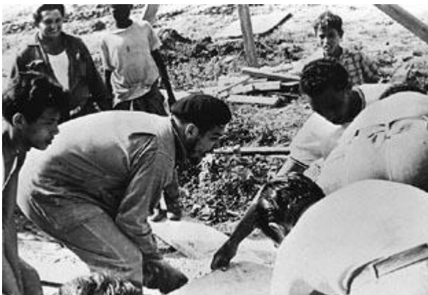
Sistemazione di pannelli prefabbricati
